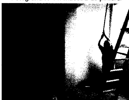
Fotografía N°12: trabajo de pintura en área de administrativa.
